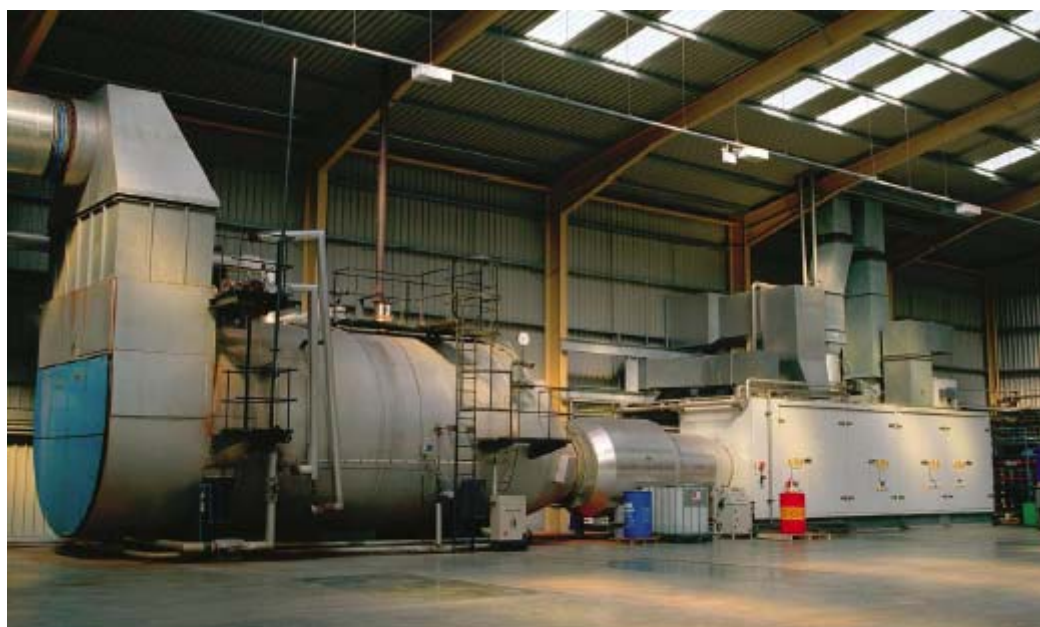
یک نمونه واحد تولید همزمان توربین گاز در کشور آلمان
